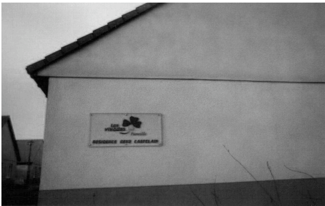
Figure.2 : Panneau d'entrée de la résidence René Castelain, lotissement de logements VIVADES 9 Familles de Pas-de-Calais Habitat dans la commune de Sauchy-Cauchy (photo de M.Delannoy) 10
