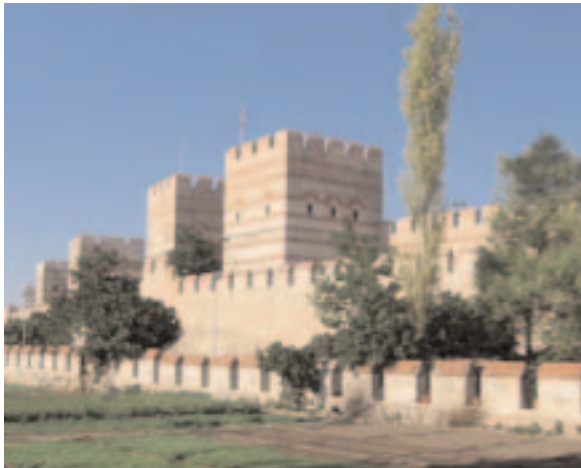
Rénovation de la Porte de Belgrade (©FD).
