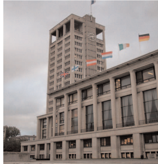
Figure 2 : La mairie du Havre, œuvre monumentale d'Auguste Perret. Cliché : Maria Gravari-Barbas, 2003
