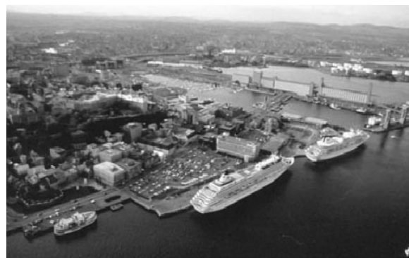
Figure 8 : Québec, l'aménagement du front de Saint Laurent. On peut remarquer l'exiguïté du front de fleuve public et la coupure entre la ville historique et le front d'eau.
