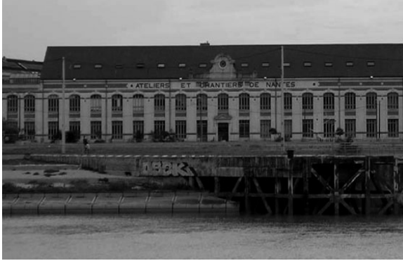
Le bâtiment des anciens chantiers Dubigeon après réhabilitation
