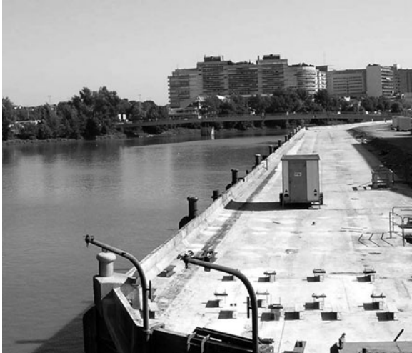
Le retraitement du quai François Mitterrand
